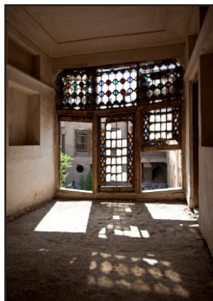
تصویر ۲۴. اتاق بالاخانه جبهه غربی (عکس از: فرشید نصرآبادی، ۱۳۹۲).
